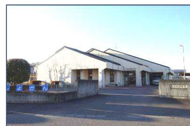
旧矢吹町図書館
