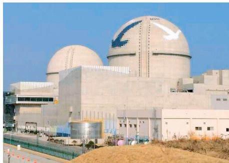
韓国・古里原子力発電所
