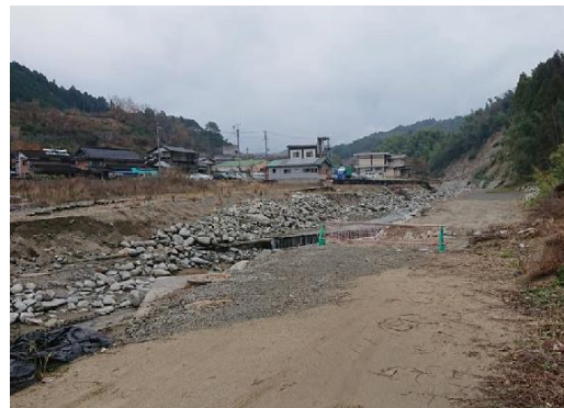
写真2 福岡県朝倉市の豪雨災害の現場
