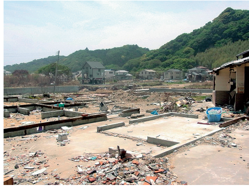
いわき市における津波被災状況 (豊間地区)
