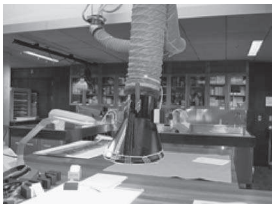
写真4 埃の吸引機 通称“Elephant Trunk”
