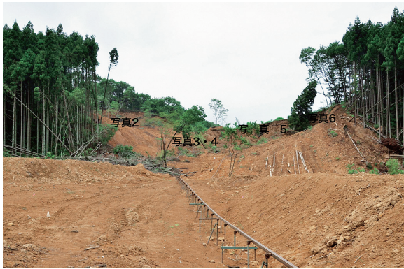
図3-1 葉ノ木平の地すべり地の全景 崩壊した土砂は、住宅があった図3-1撮影地点になだれ込んだ。図中に写真2、3、4の位置を示す。
