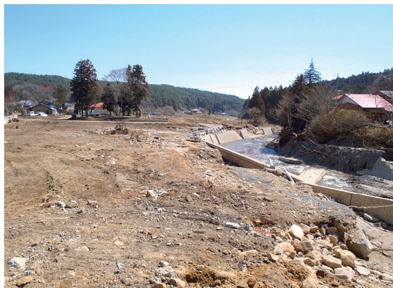
図4-3 滝集落の氾濫現場 (2011/04/11撮影)
