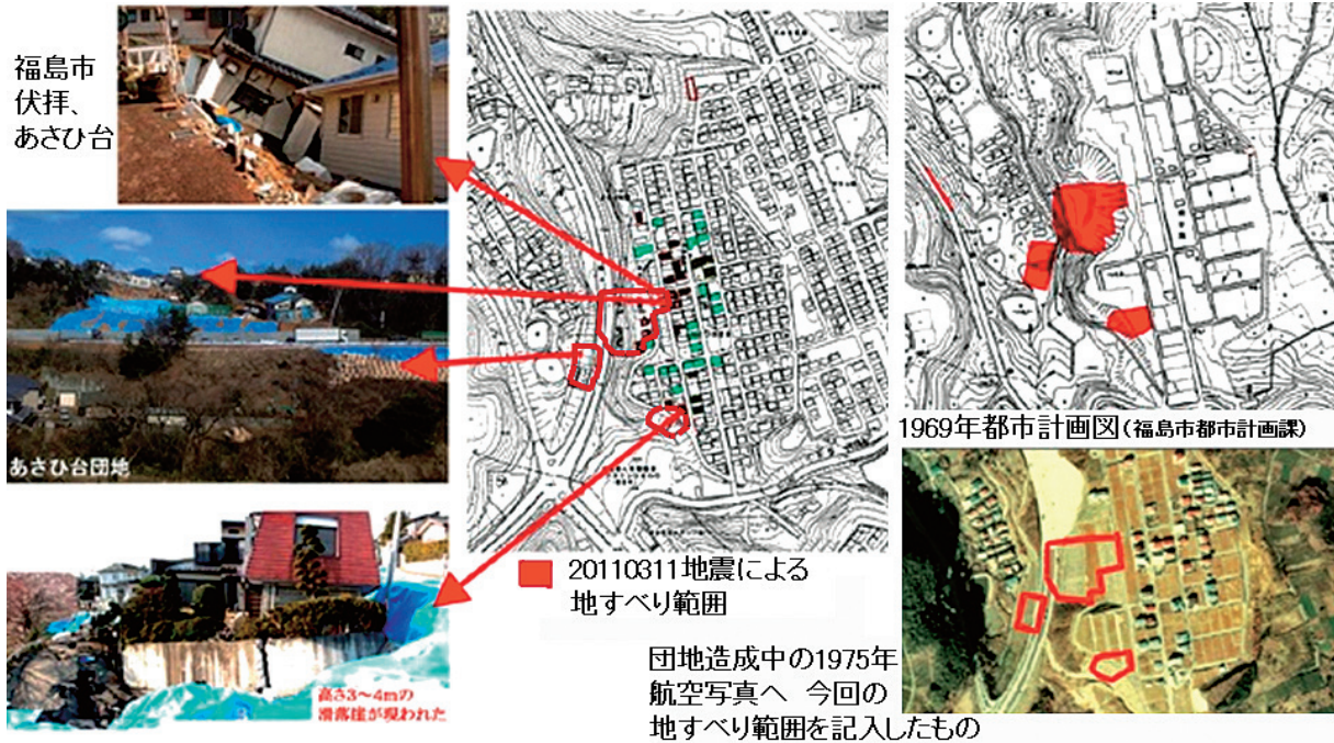
図2-2 福島市伏拝、あさひ台の人工地盤の崩壊地すべり 1969年東北都市計画図は福島市都市計画課提供。
