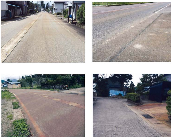
図 3 道路状況区分
